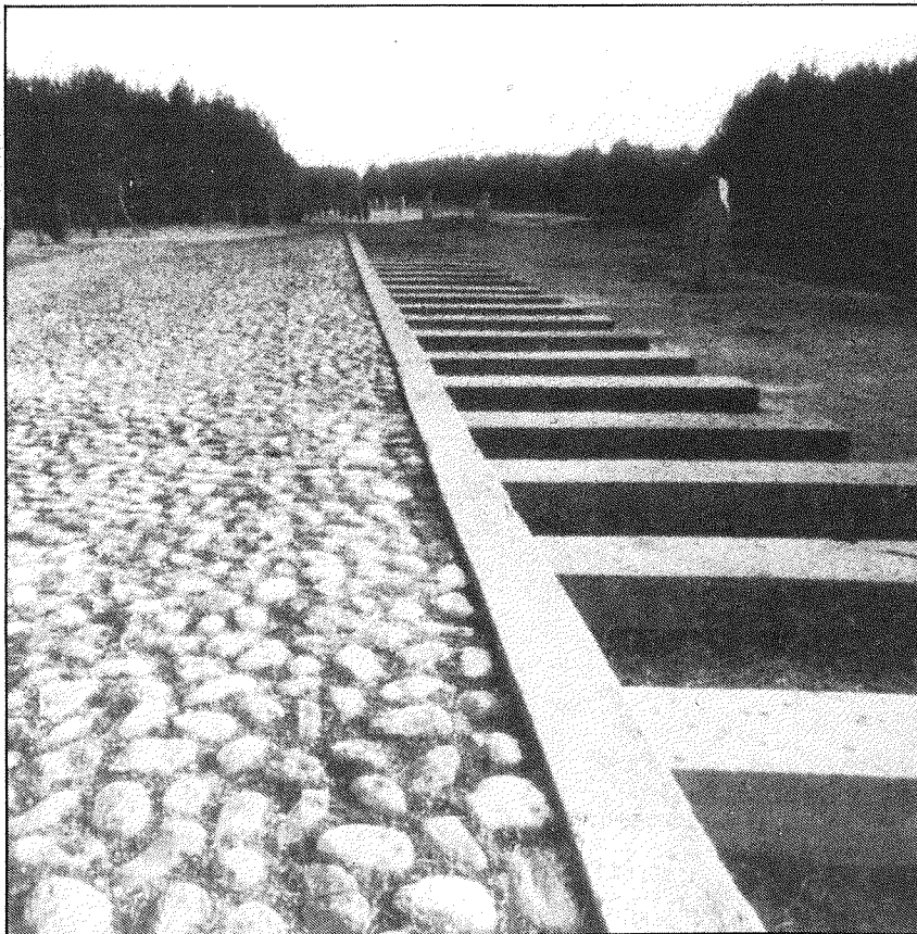
Endstation Todeslager: Granitblöcke in der Horizontalen markieren die Bahnstrecke
